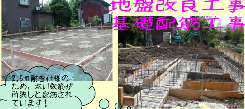
2.5m耐雪仕様のため、太い鉄筋が所狭しと配筋されています！
